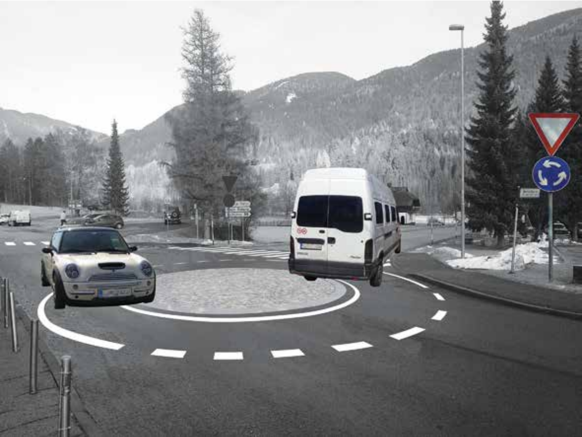
POGLED NA UREDITEV PO IZVEDBI - MANJŠE KROŽIŠČE S POVOZNIM SREDINSKIM OTOKOM
